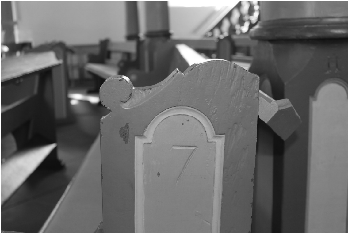
Abb.5: Aufrechtes Wangenelement mit seitig bestoßenen Fassungsschichten.
