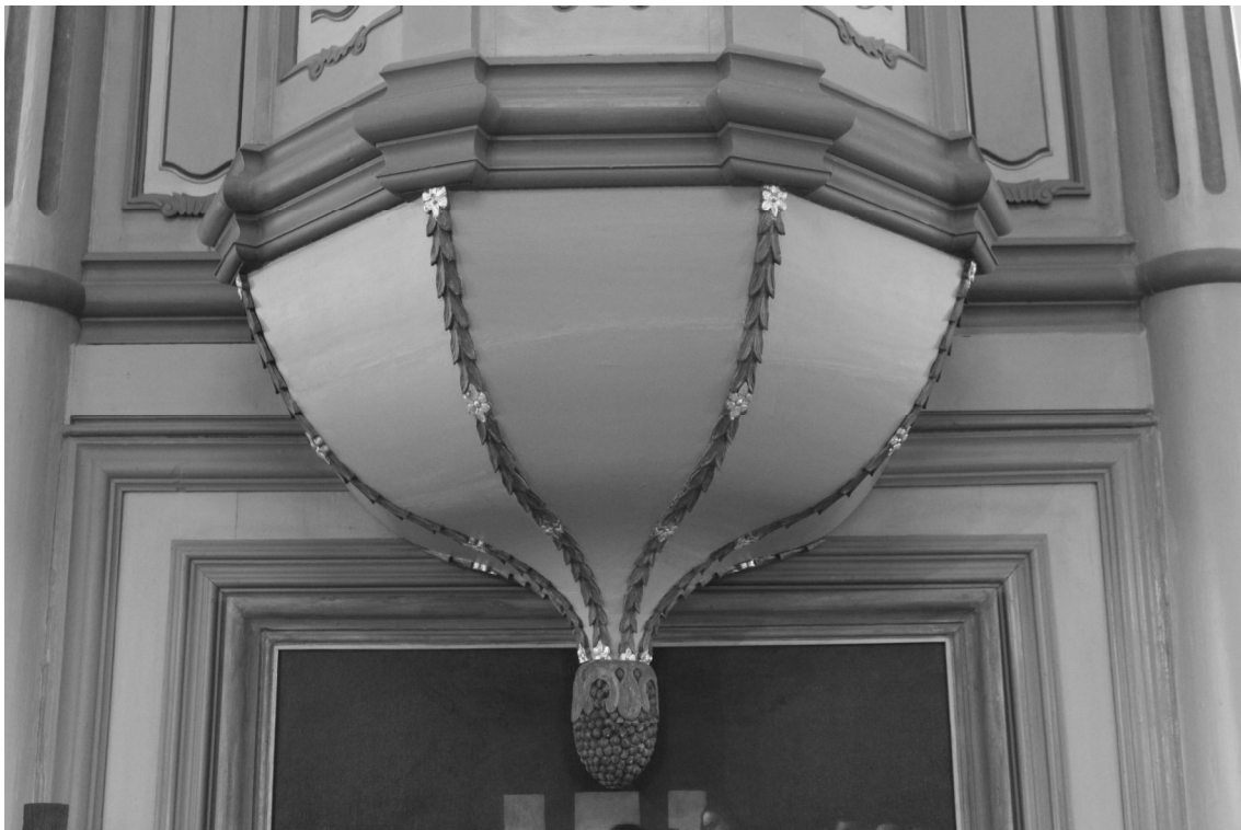
Abb.28: Zierunterbau des Kanzelkorbes, Endzustand.
