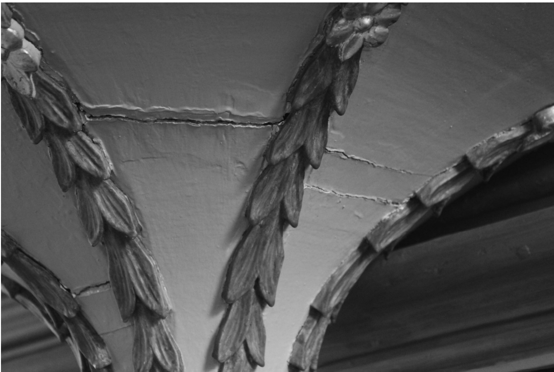
Abb.7: Zierunterbau des Kanzelkorbes mit Trockenrissen.
