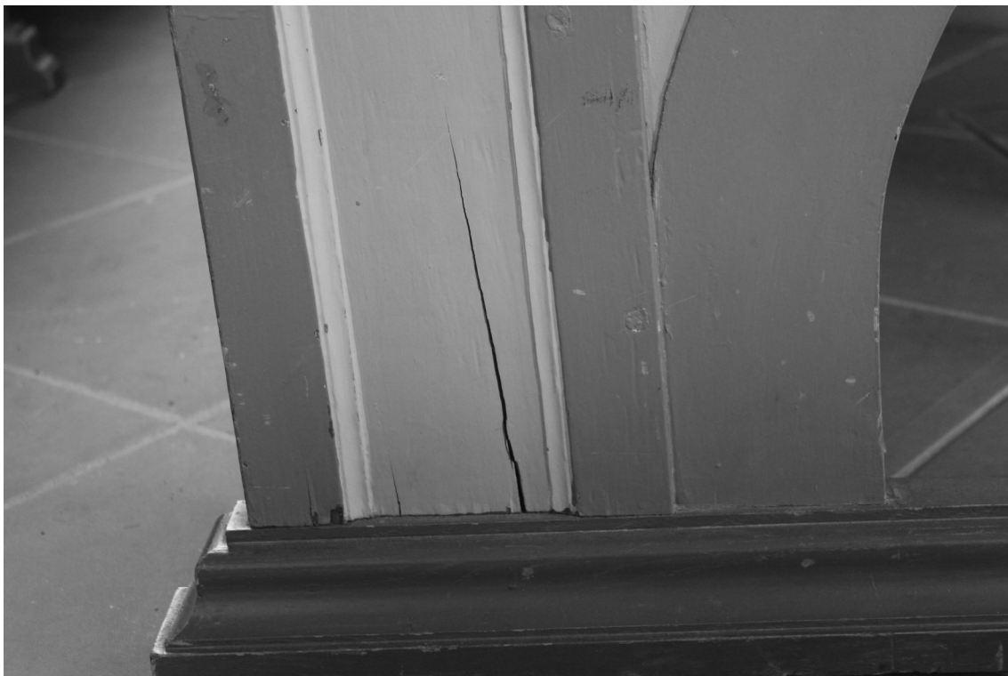
Abb.2: Kufe und aufrechtes Wangenelement, Trockenriss und bestoßene Fassungsschicht.
