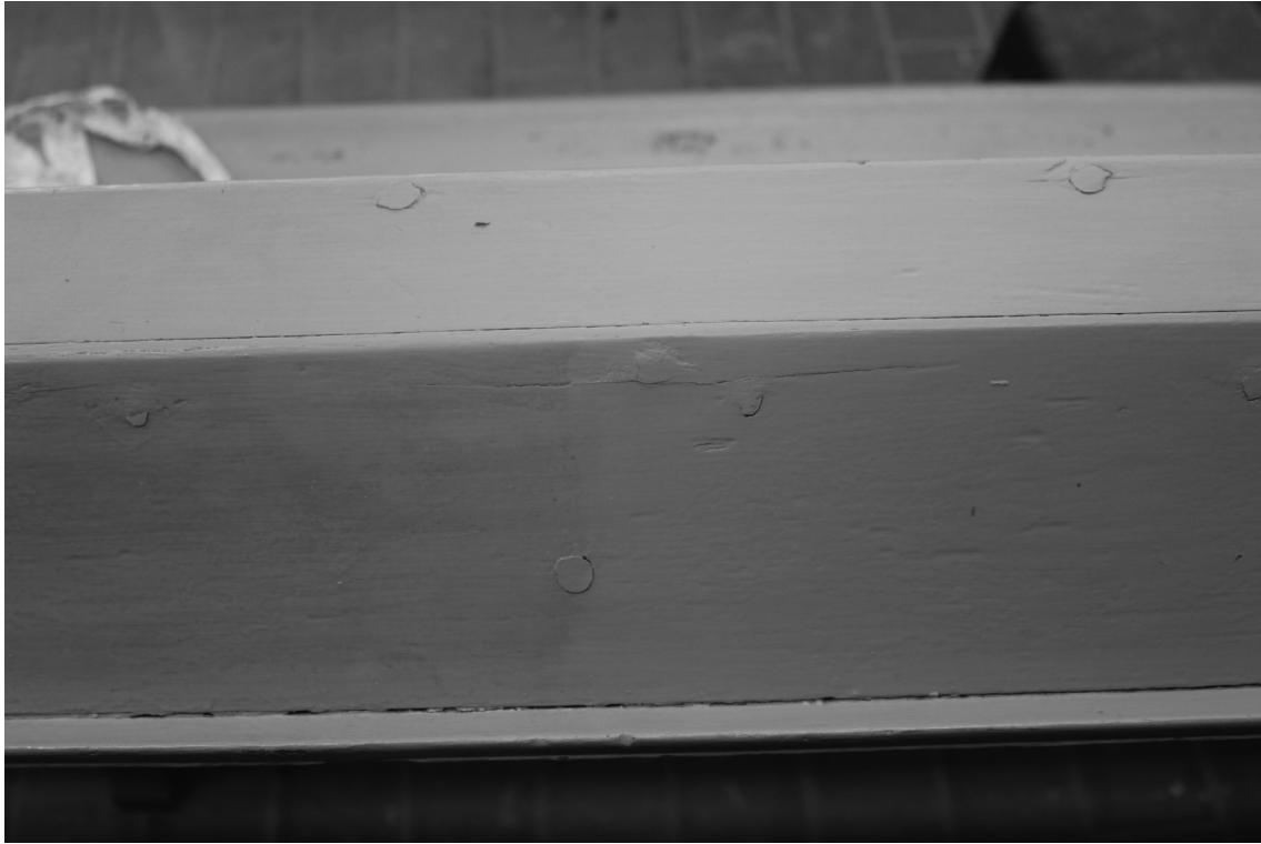
Abb.15: Gesangbuchauflage, Reinigungsprobe. Linker Bereich ungereinigt, rechter Bereich nach Abnahme der Verschmutzungen.
