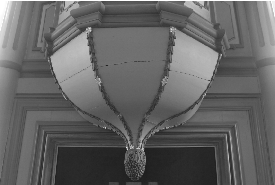
Abb.7: Zierunterbau des Kanzelkorbes mit Trockenrissen.
