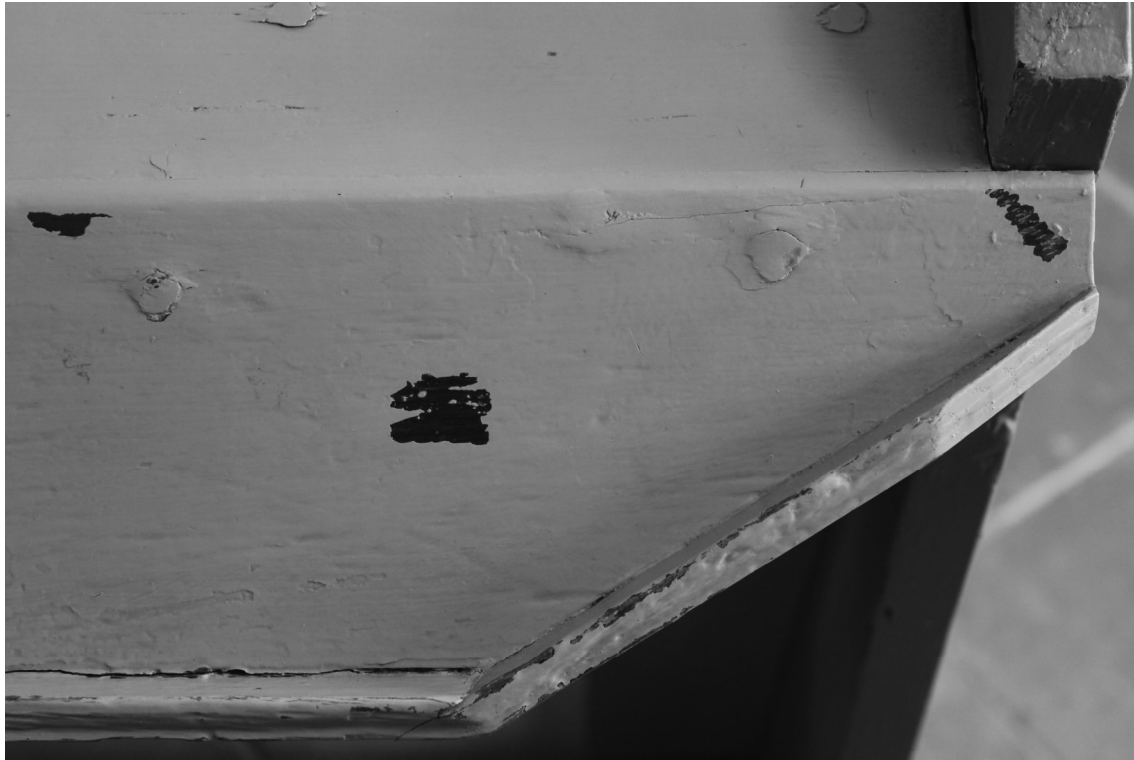
Abb.3: Gesangbuchauflage, Detailansicht mit Fassungsverlusten. Darunter erkennbar die braune Holzimitationsmalerei.
