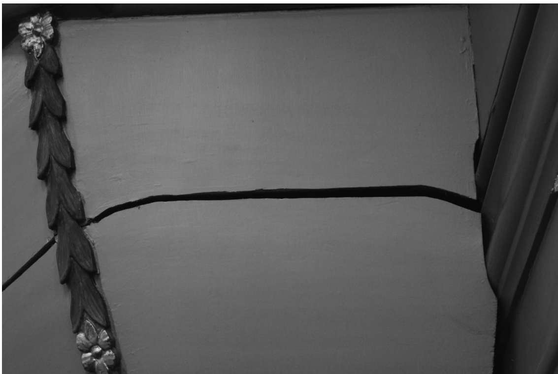
Abb.24: Zierunterbau des Kanzelkorbes nach Entfernung der alten Kittreste.
