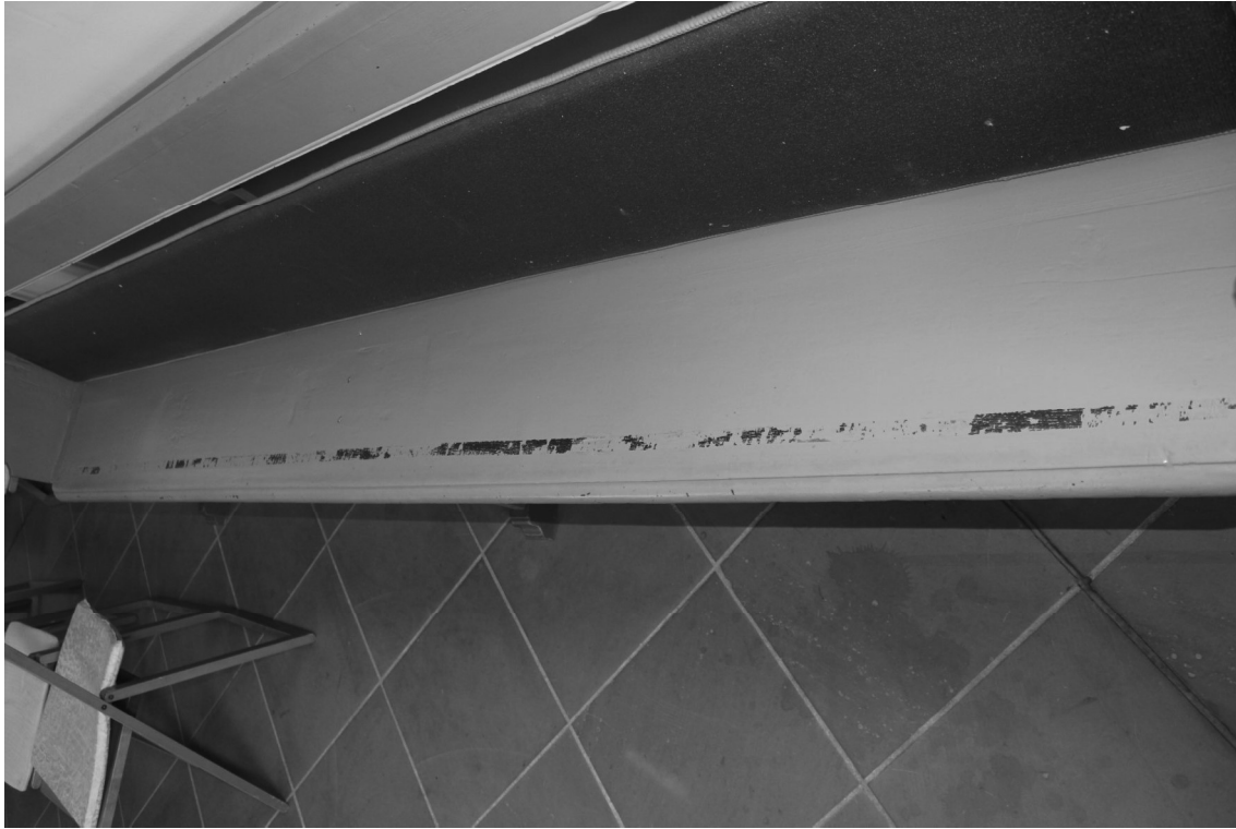
Abb.11: Sitzfläche durch Abziehen der Klebestreifen großflächig abgelöste Fassungsschichten.
