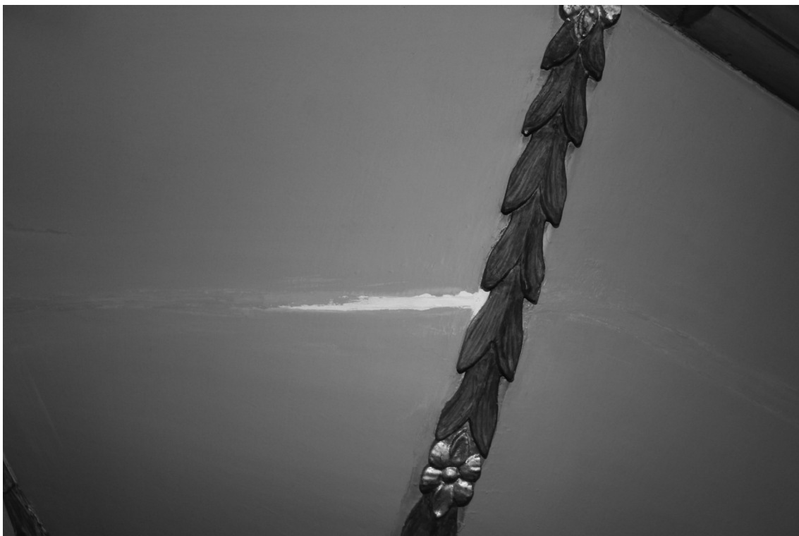
Abb.26: Zierunterbau des Kanzelkorbes, beigearbeitete Balsaholzstreifen nach partiellen Kittungen und begonnenen Retuscharbeiten.
