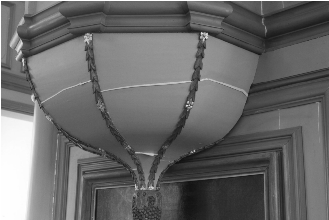
Abb.25: Zierunterbau des Kanzelkorbes, mit eingepassten Balsaholzstreifen.
